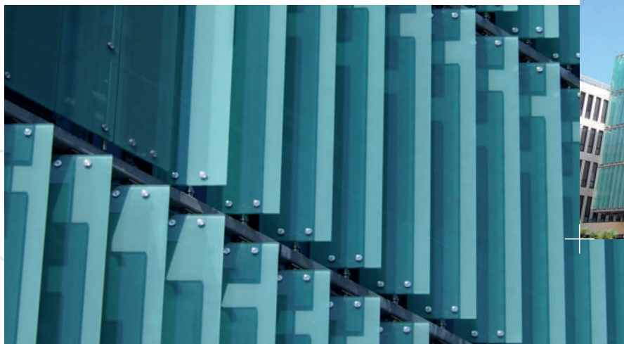
L'UNIVERSITÉ DES QUAIS - LYON : Brise-soleil orientables motorisés verticaux
