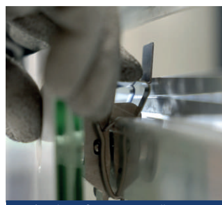
Insérez l'agrafe pour verrouiller le panneau horizontalement.
