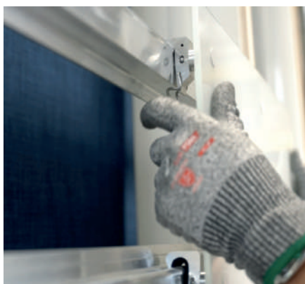
Insérez la bague et la vis dans le trou fraisé du panneau et vissez-les avec le crochet.
