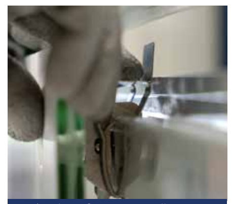
Insérez l'agrafe pour verrouiller le panneau horizontalement.
