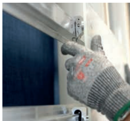
Insérez la bague et la vis dans le trou fraisé du panneau et visez les avec le crochet.
