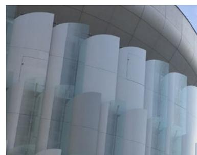
**béton flottant**, au dessous de laquelle s'articulent des **façades en écailles de verre** et d'aluminium.
